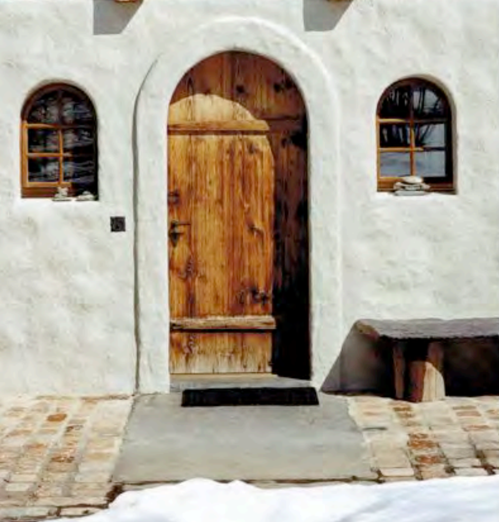
L'ENTRÉE DU CHALET avec son soubassement en pierres crépies, sa porte basse et protégée, ses petites lucarnes... Traditionnelle.
